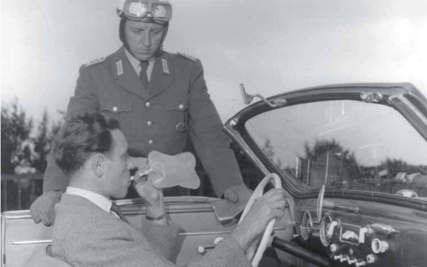
Bild 4: Einsatz der ersten im Jahr 1953 entwickelten Alcotest-Röhrchen
